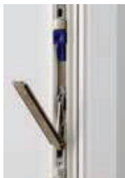
Verrouillage du vantail secondaire.
